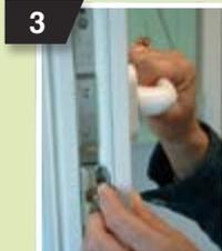
Remettre la poignée à l'horizontale en actionnant l'anti fausse manoeuvre et en maintenant l'ouvrant vertical.
