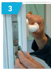
3 Remettre la poignée à l'horizontale en actionnant l'anti fausse manoeuvre et en maintenant l'ouvrant vertical.
