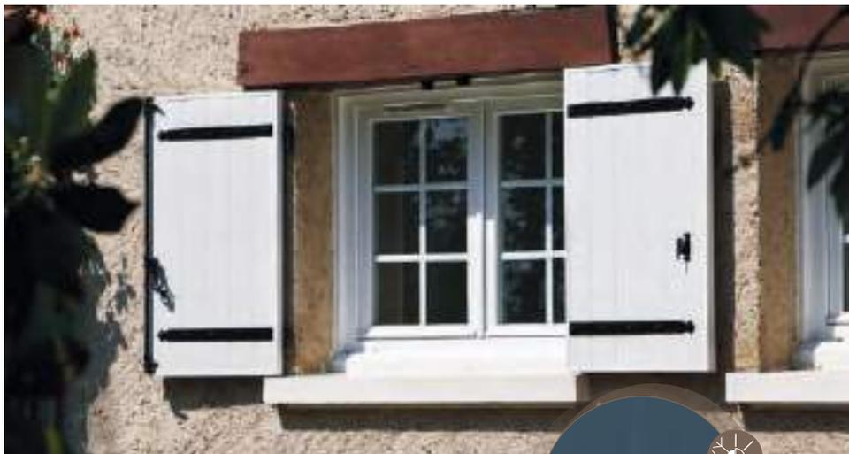
Les volets en ALU ISO sont constitués d'une âme isolante poly composant pour garantir d'excellentes performances thermiques.
