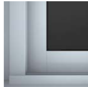
Détail ext. : partie inférieure drainage caché
